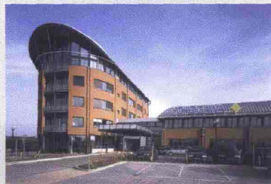
La nuova sede Yokogawa ad Ameersfort (Olanda)
